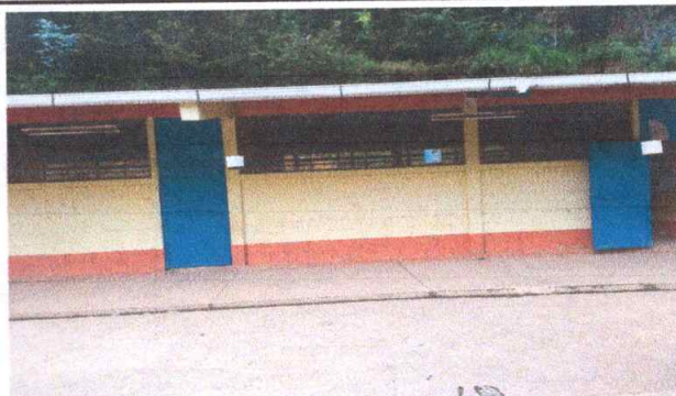
Foto 2: PINTURA EN MUROS EXTERIORES E INTERIORES MODULO II, MARCA EXCELLO LATEX ACRILICA SHERWIN WILLIAMS
