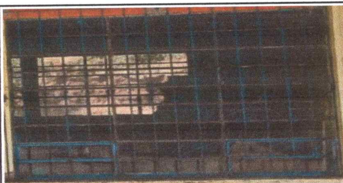
Foto 6: FABRICACIÓN E INSTALACIÓN DE BALCÓN
